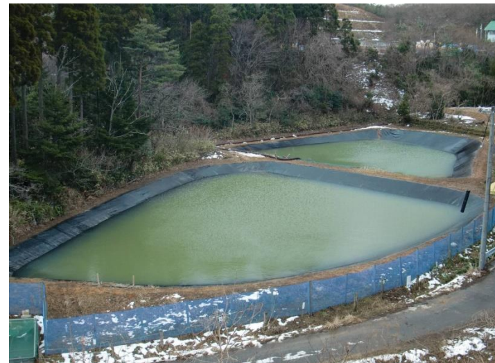
凝集剤添加処理後の沈殿池 (ss ≒ 10mg/l)
