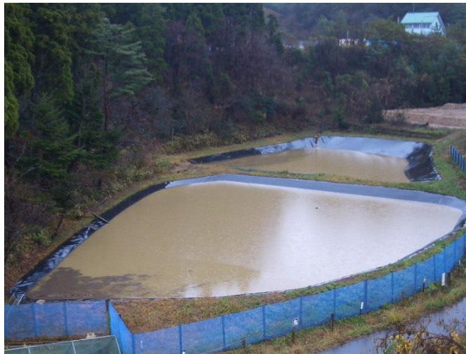
処理前の沈殿池 (ss ≒ 3000mg/l)
